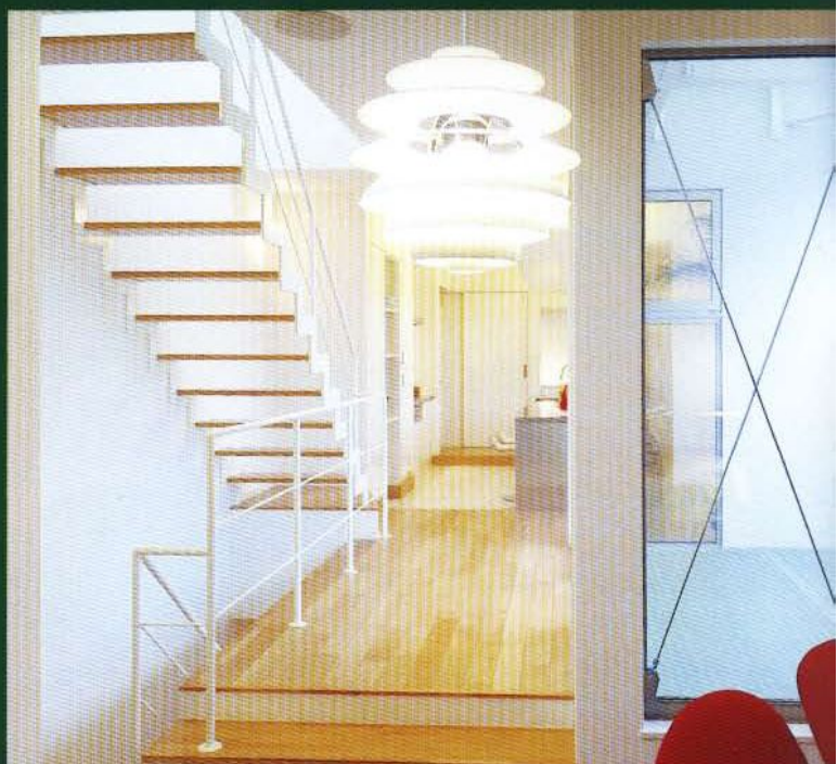
■スマート・ブレース設置例（内側）
